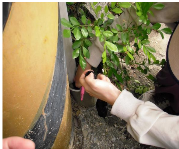
地下電纜引上管
