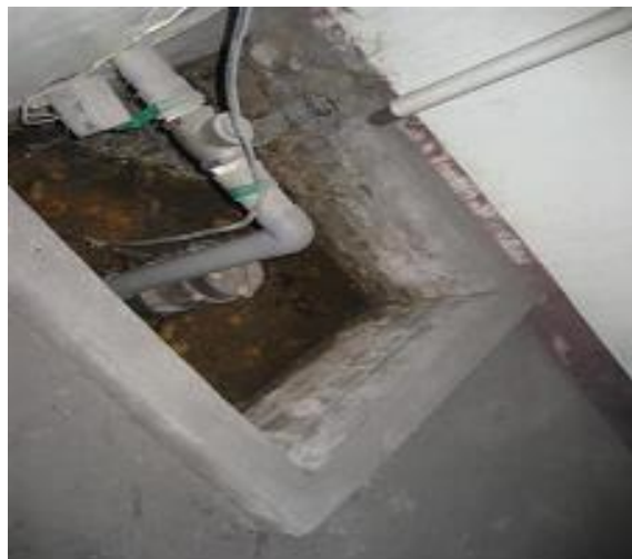
地下室儲水槽
