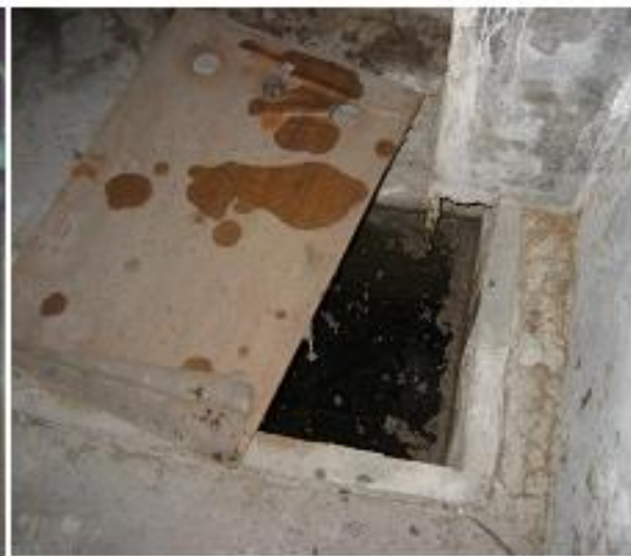
地下室污水池
