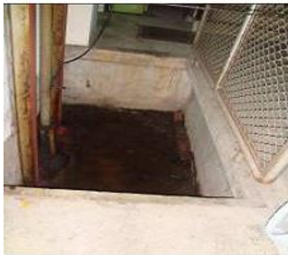
地下室之升降梯孔積水
