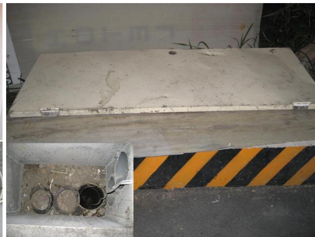
電信電纜管道
