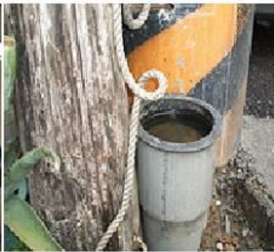
台電地下電纜引上管
