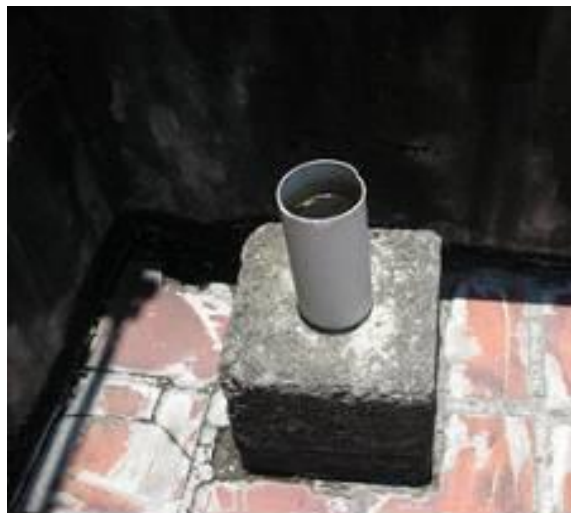
水泥樁上之水管
