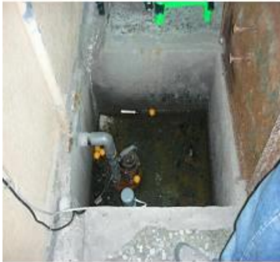
地下室集水槽
